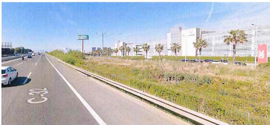
Imagen: gestión de la zona de afección de carretera C-32 permitiendo gran visibilidad de la edificabilidad. Villadecans Bussines Park (Villadecans-Barcelona)
